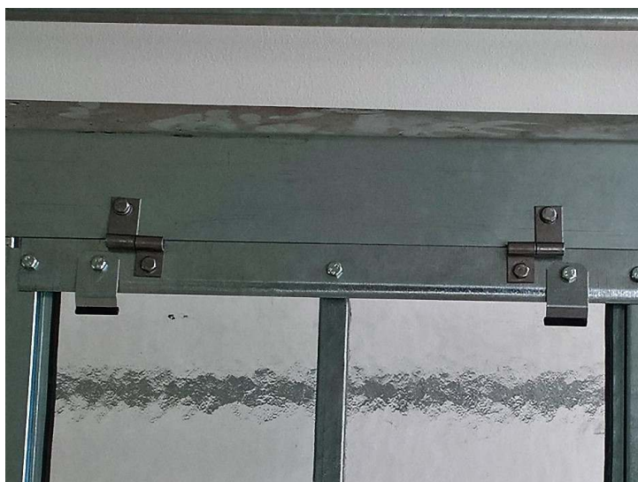
Pomocí kleští jemně přitlačíme příchytku (poz. 83-
