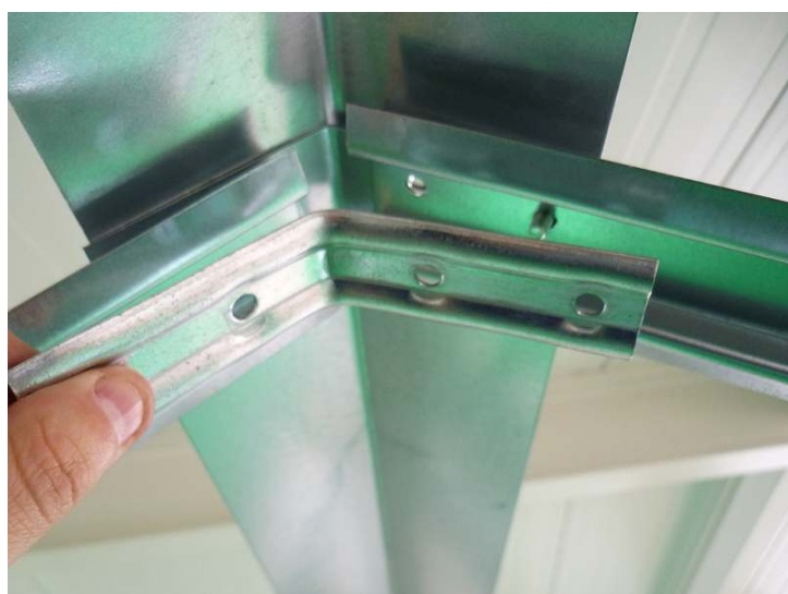
Detail spojení sloupků se sedmi otvory (poz. 5) a hřebenových spojovacích plechů (poz. 18).
