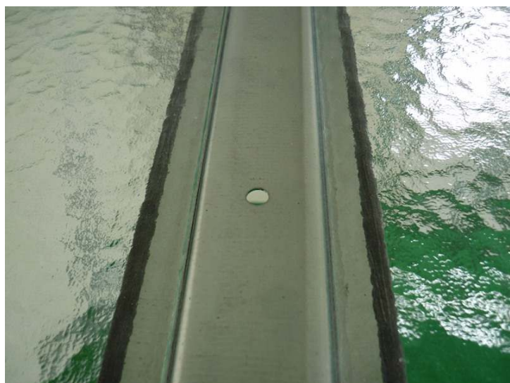
Přichycení střešního skla přičtykou poz. 83-2. Pod tyto přičtyky můžeme zevnitř skleníku umístit vyvazovací pásky, pozice 84-2
