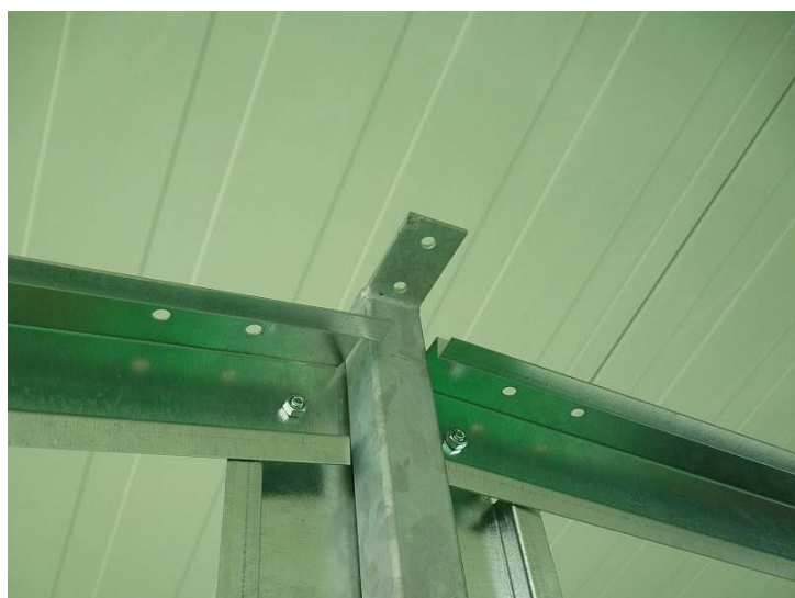
Montáž hřebenového spojovacího plechu (poz. 18-1, 18-2, 18-3) K čelní jácklové výztuze (poz.42) přichytíme hřebenová spojovací plech krajní (poz. 18-1).
