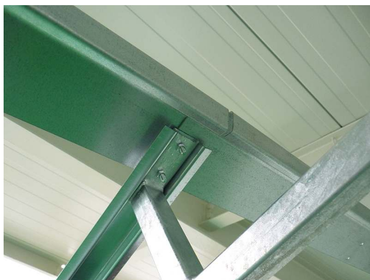
Spojovací střešní plech spojíme přes sebe s jácklovou výztuhou a sloupkem se sedmi otvory.
