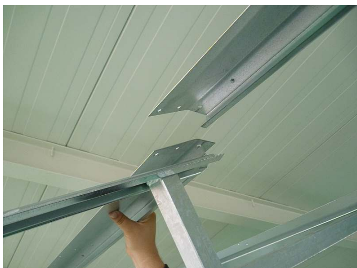
Spojovací střešní plech spojíme přes sebe s jácklovou výztuhou a sloupkem se sedmi otvory.
