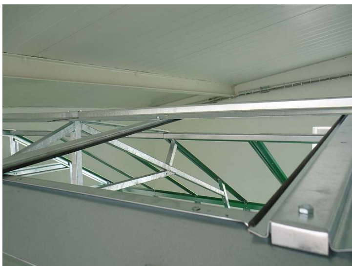
Detail zasklení hřebenové části.
