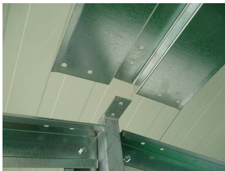
Montáž hřebenového spojovacího plechu (poz. 18-1, 18-2, 18-3) K čelní jácklové výztuze (poz.42) přichytíme hřebenová spojovací plech krajní (poz. 18-1).
