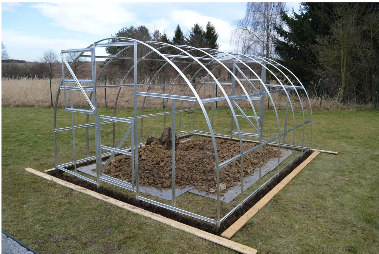
Ilustrativní obrázek ukotvení konstrukce do země
